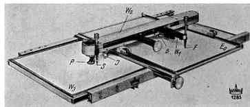
Abb. 16: Differential-Integraph nach v. Harbou, Askania (Meyer zur Capellen, 1949)
